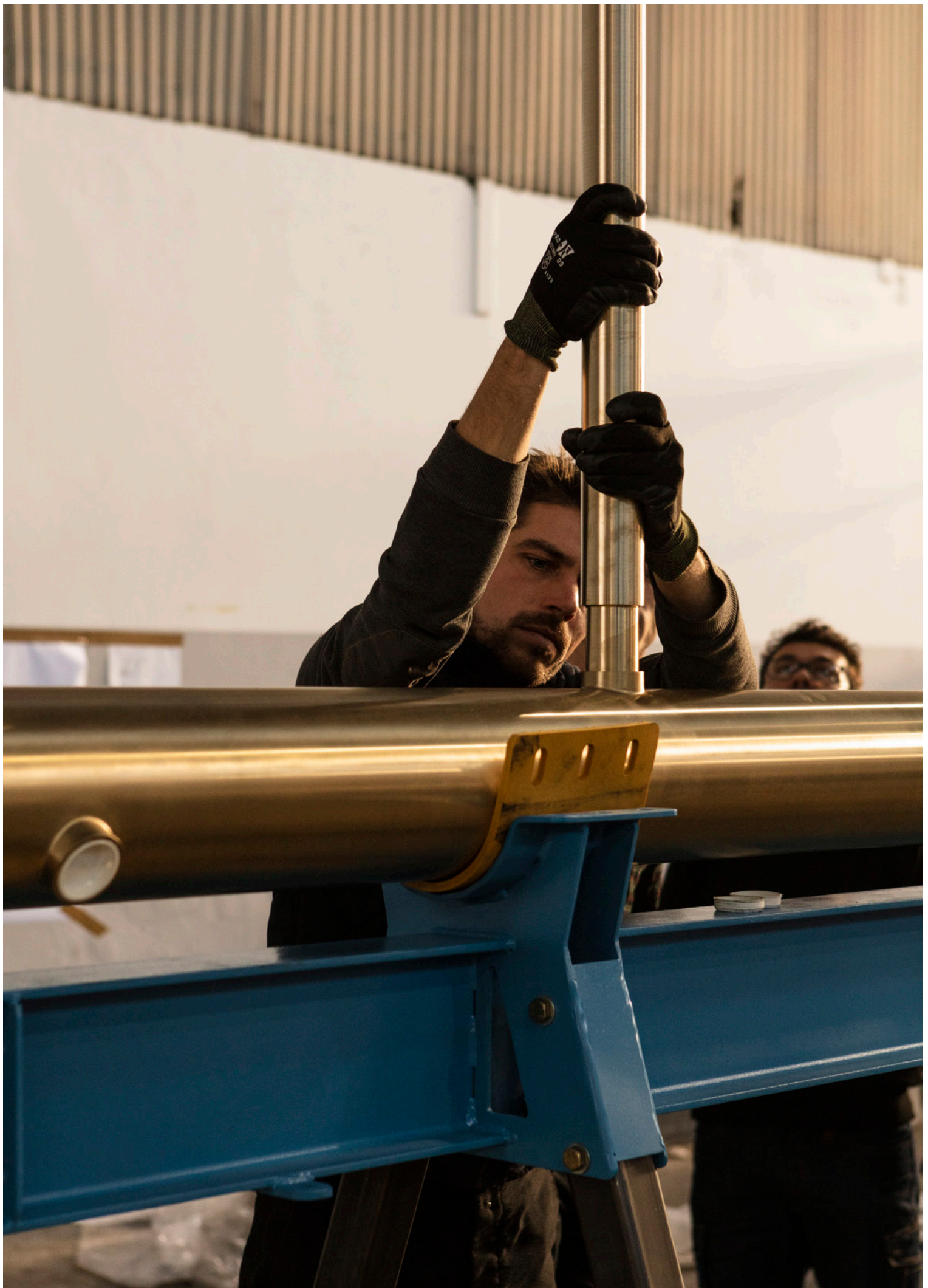
Assemblage des mâts des fontaines
